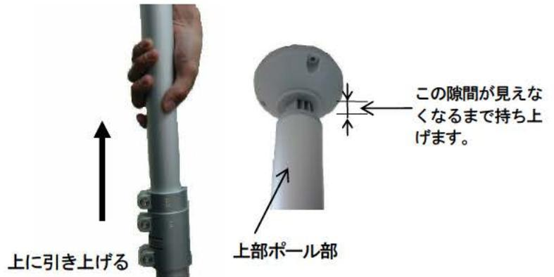
3) 2) の状態を保持しながら、1) で緩めたブラケットの上部ボルトを締め直し、次に下部ボルトが緩んでいないかを、確認し緩んでいる場合締め付けます。
